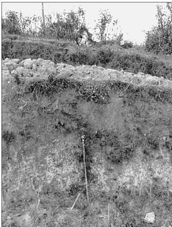
Небольшой оползень, заложенный в толще покровных суглинков.
